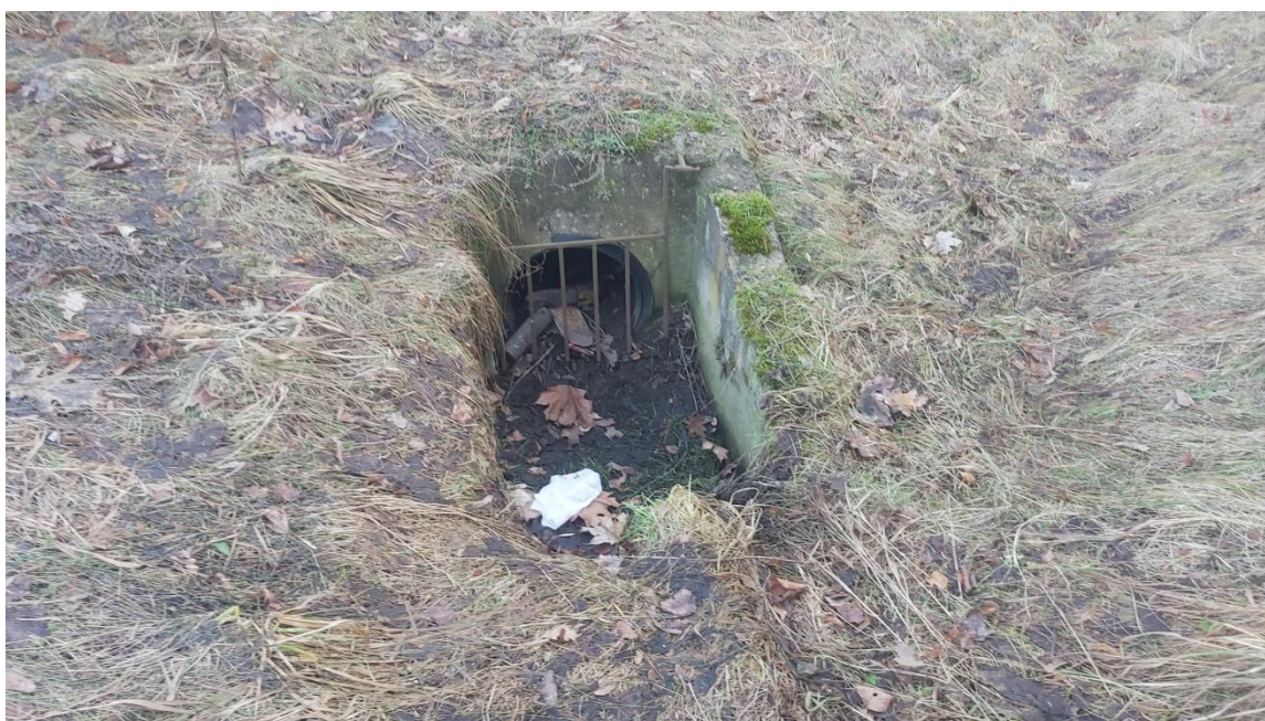
Rys.1 Przepust nr 1 z HDPE przy drodze wojewódzkiej numer 665 średnicy 400 mm.
