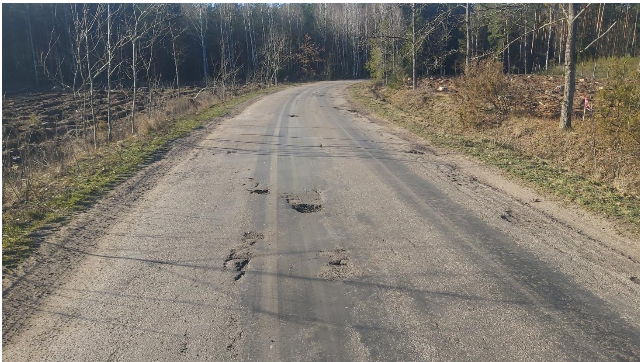
Rys.7 Ubytki w nawierzchni.
